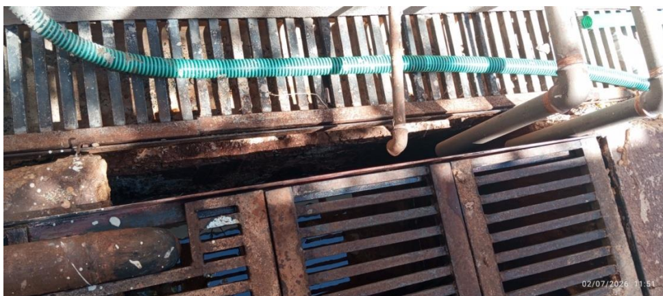
Εικόνα 2: Κανάλι αποστράγγισης εφαπτόμενο στο δοχείο στρατσωνισμού.
