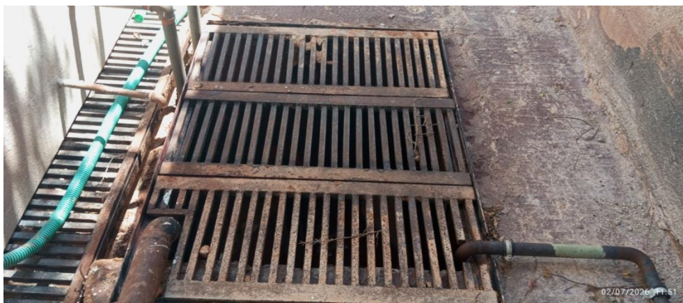
Εικόνα 1: Υφιστάμενο φρεάτιο στρατσωνισμού.
